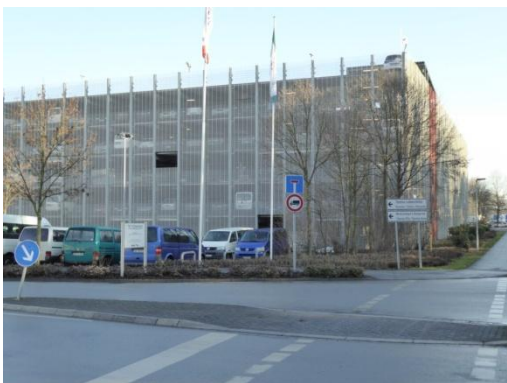
Abb. 51: Beispiele für eine Stellplatzlösung in Form eines Parkdecks Fa. Tönnies Lebensmittel GmbH & Co. KG (Rheda-Wiedenbrück)
