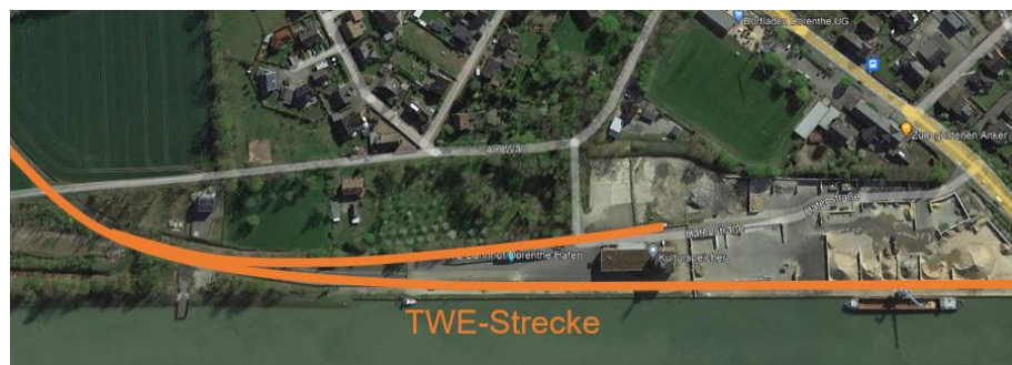
Abbildung 7: Luftbild des Hafengebiets Dörenthe (Google Earth, 21.03.2024)
